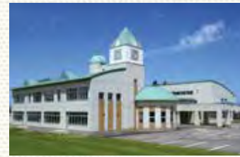
廃校となった施設を再利用した工場
